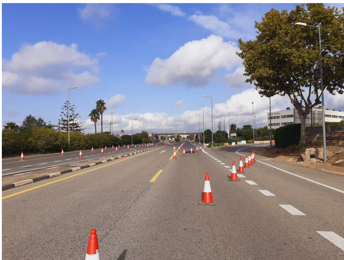
Imatge de la zona de les obres | Reus.cat
