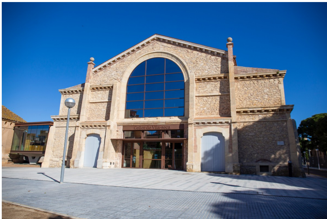
Imatge de la façana del celler vila-secà | Cedida
