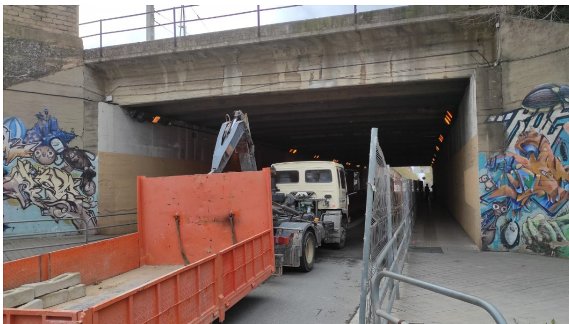
Imatge d'arxiu de l'inici de les obres al pont del barri Gaudí | Estel Romeu
