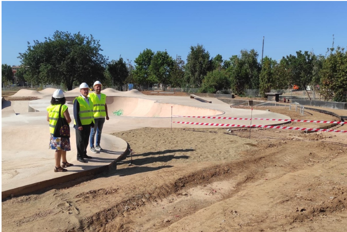
Encara falten els treballs de pavimentació, enllumenat i instal·lació de mobiliari urbà Foto: Estel Romeu
