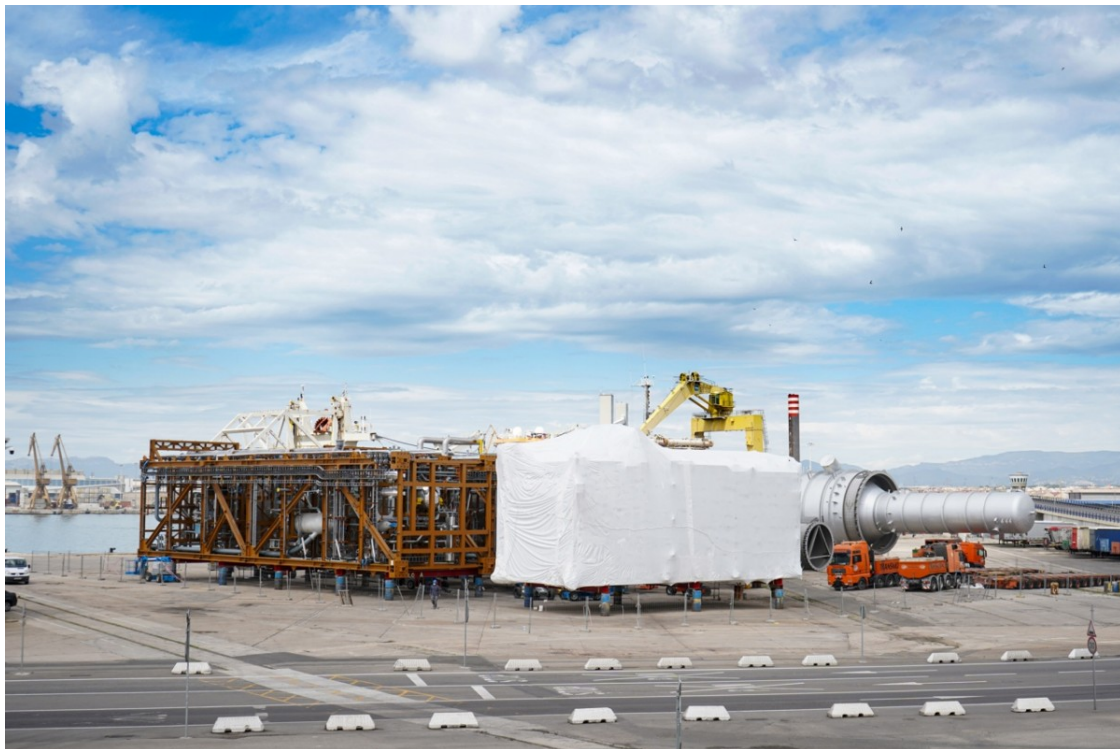
El Port de Tarragona. | Port de Tarragona
