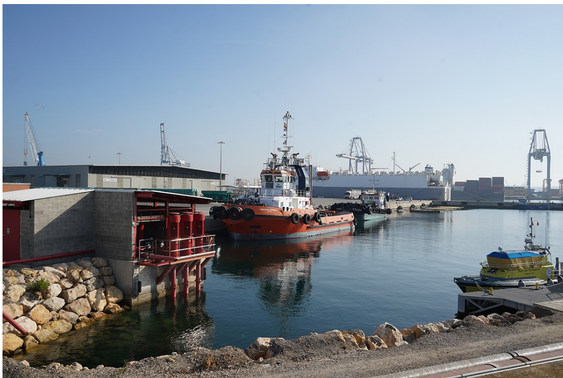
Les obres al Moll de Cantàbria, al Port de Tarragona | Port de Tarragona
