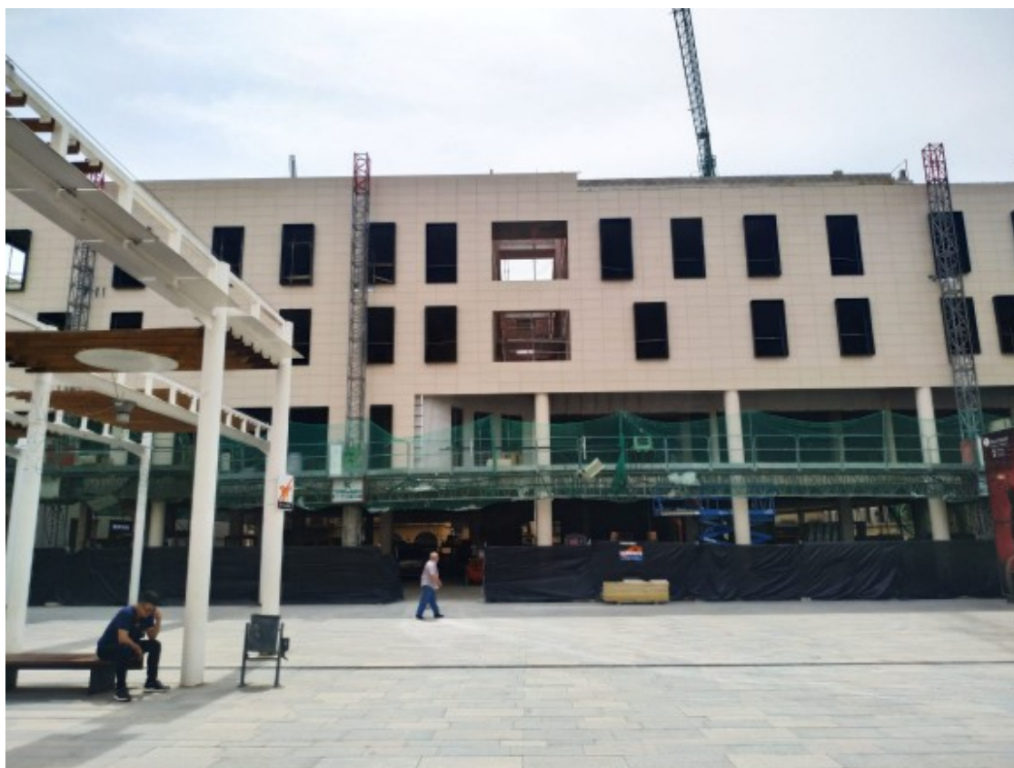
Les obres de l'hotel estan avançades Foto: MBO
