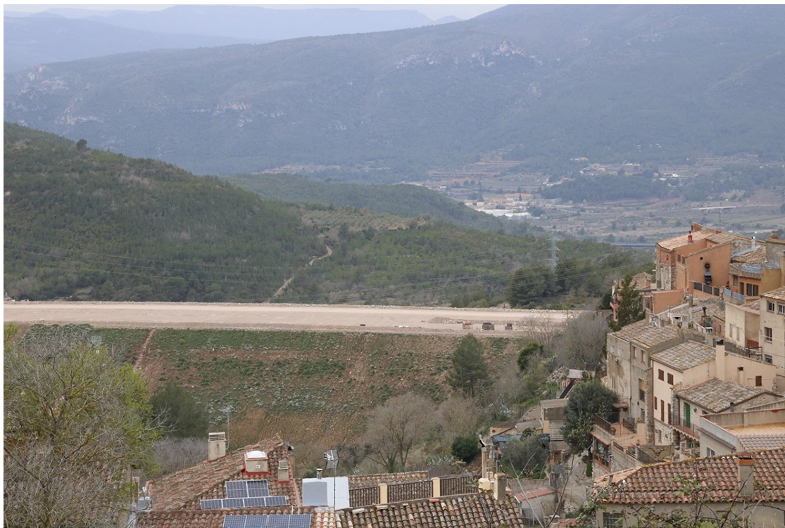
Obres de l'autovia A-27 al seu pas per la pedania de Lilla, a Montblanc. | Núria Torres/ACN
