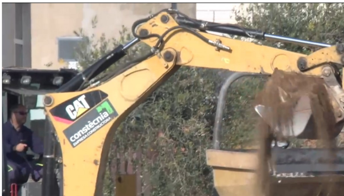
Imatge de les obres | Canal Camp
