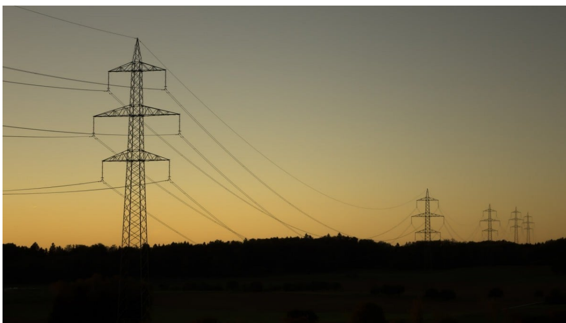
Línia de Molt Alta Tensió | Imatge d'arxiu
