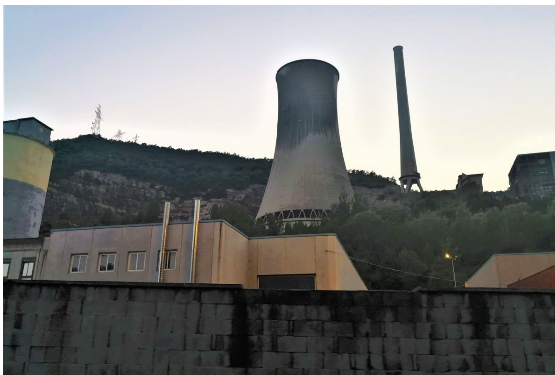
La incineradora de Cercs | ACN
