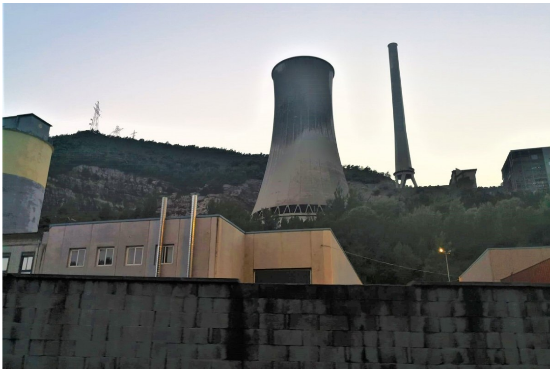
La incineradora de Cercs | ACN
