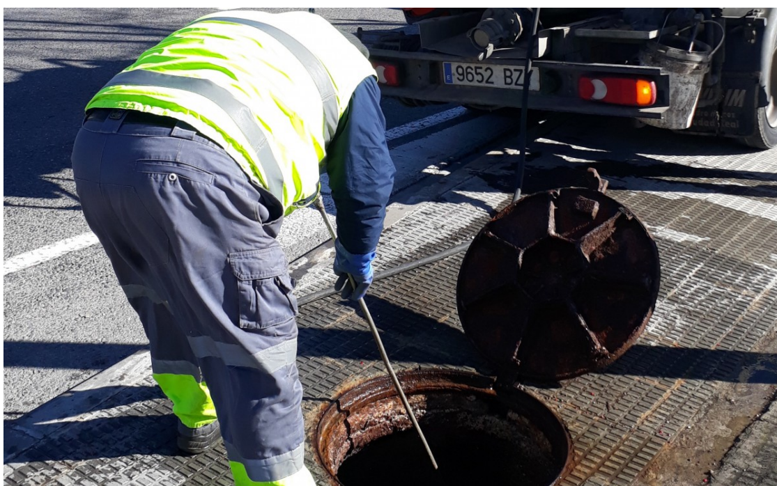
Un tècnic inspecciona una clavaguera, a Reus | Reus.cat
