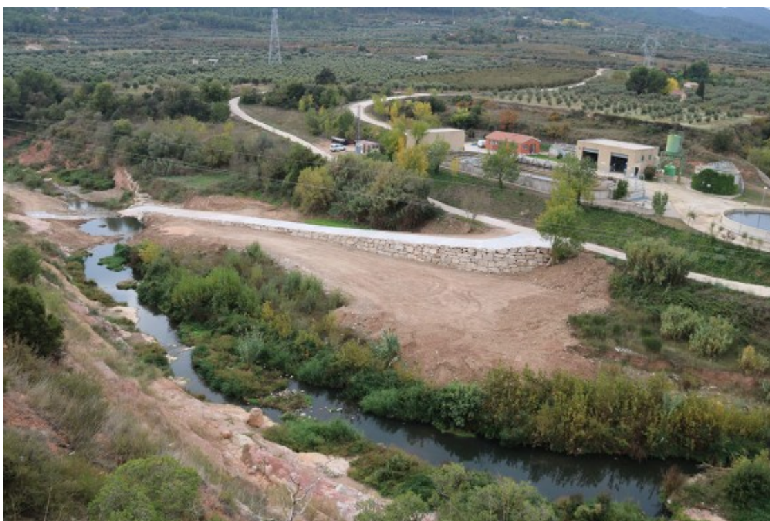
Construcció d'un pas inundable a l'entrada de l'Espluga de Francolí, en substitució d'un camí engolit per la riuada. Foto: ACN
