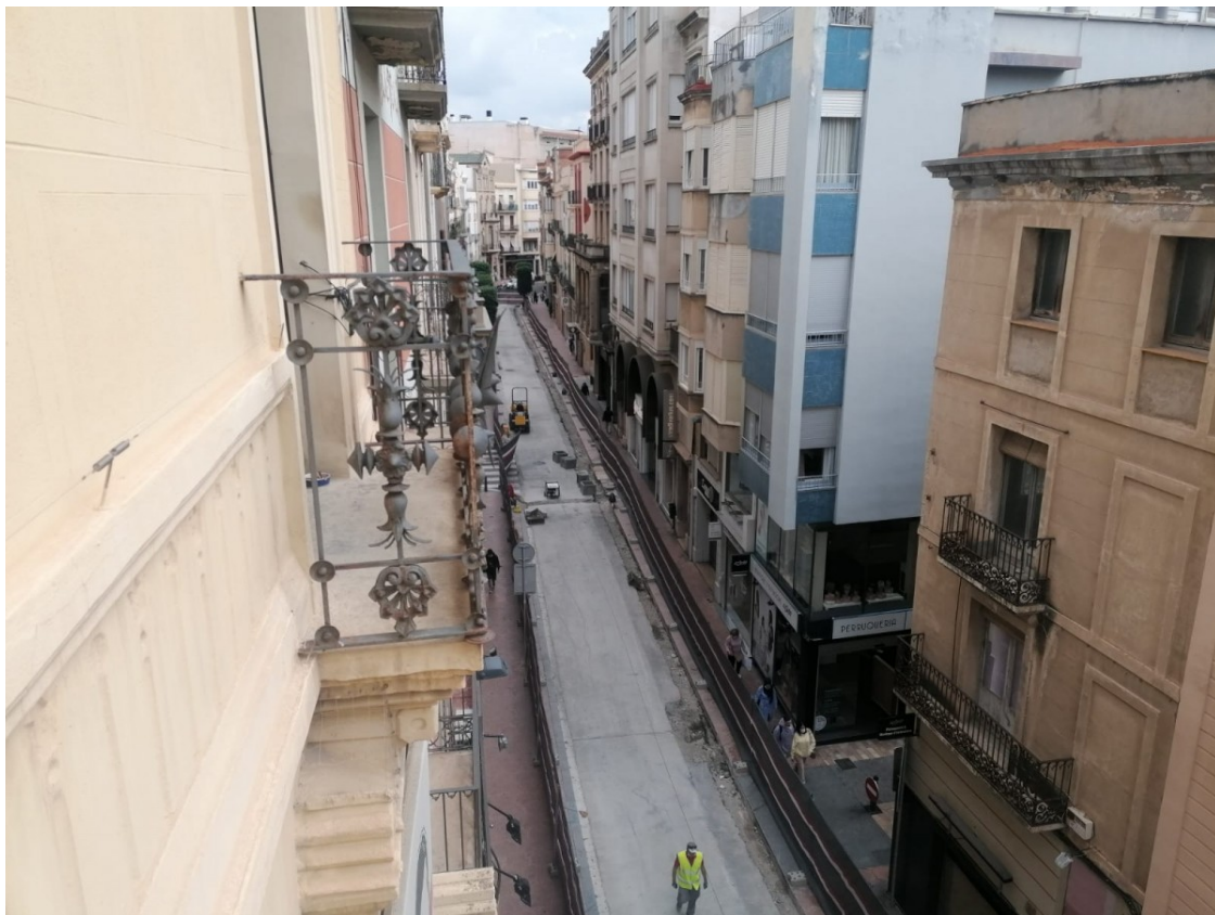
Imatge de les obres del raval de Santa Anna, el passat dilluns | Alba Cartanyà
