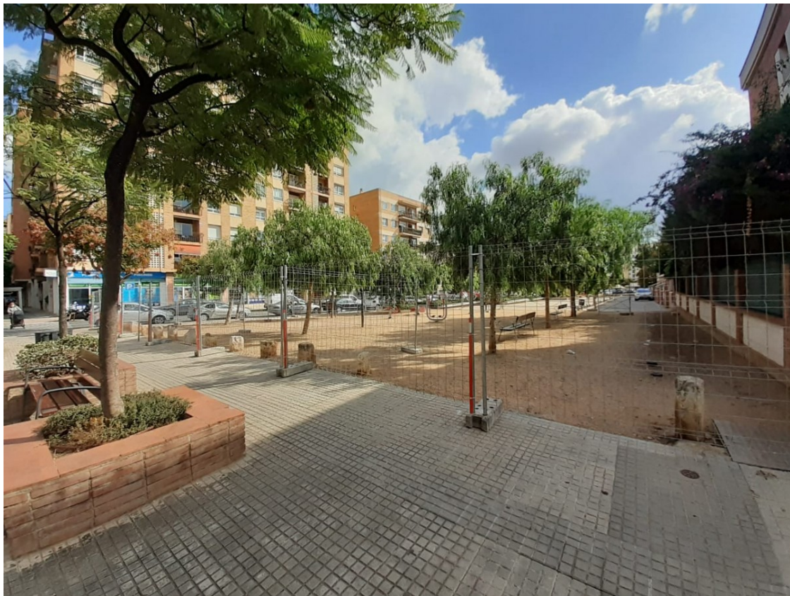
Una imatge de les obres | Ajuntament de Reus
