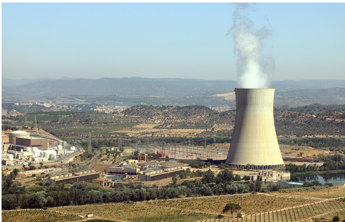
Central nuclear d'Ascó, amb la xemeneia fumejant a la dreta i els dos reactors a l'esquerra. | ACN
