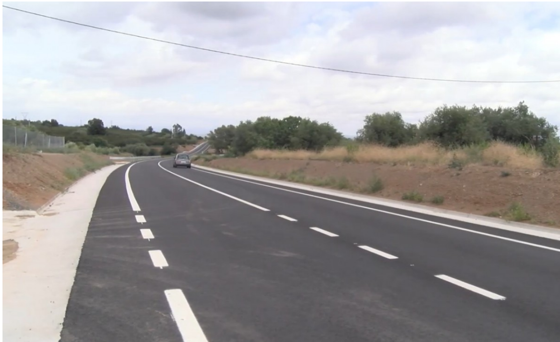
Un tram de la carretera T-3231 | Canal Camp
