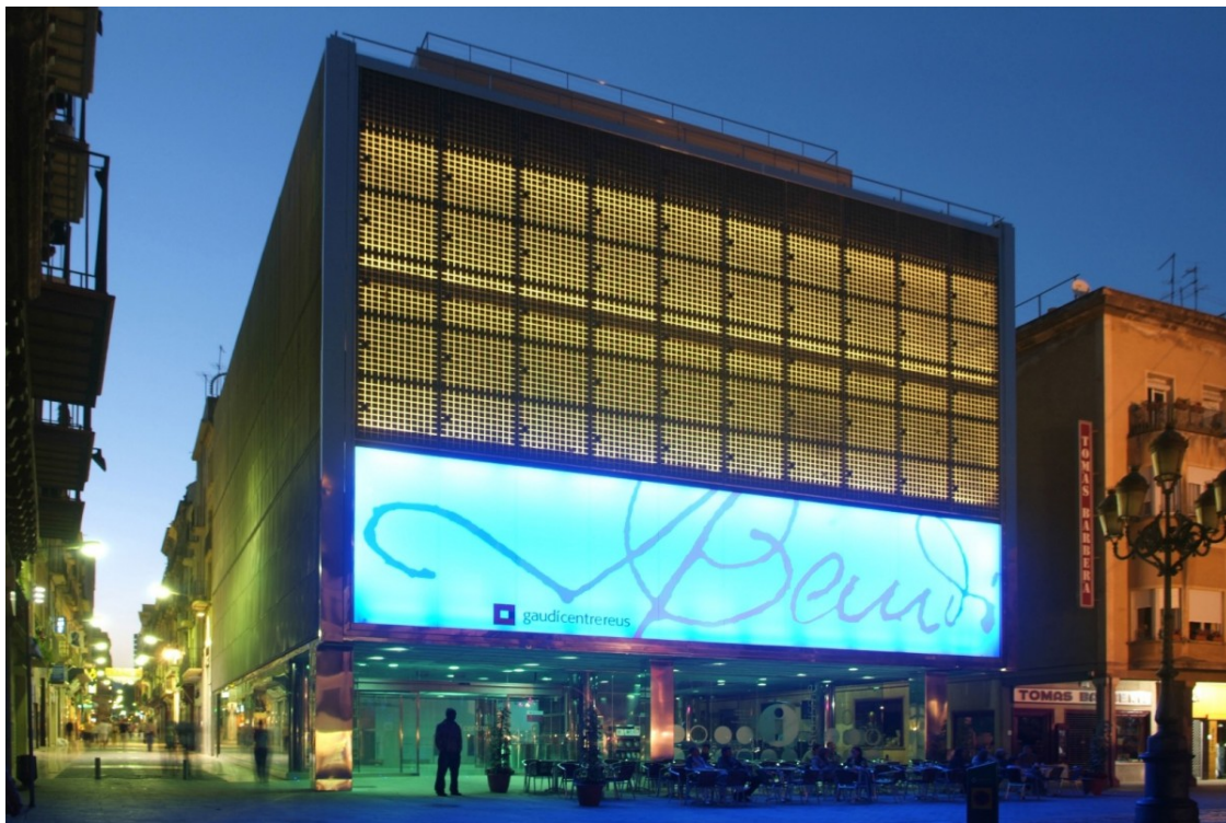
Façana exterior del Gaudí Centre | Cedida
