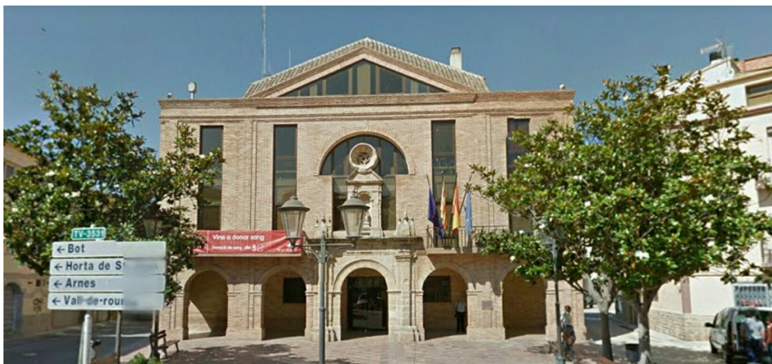
Façana de l'Ajuntament de Gandesa | Google Street View
