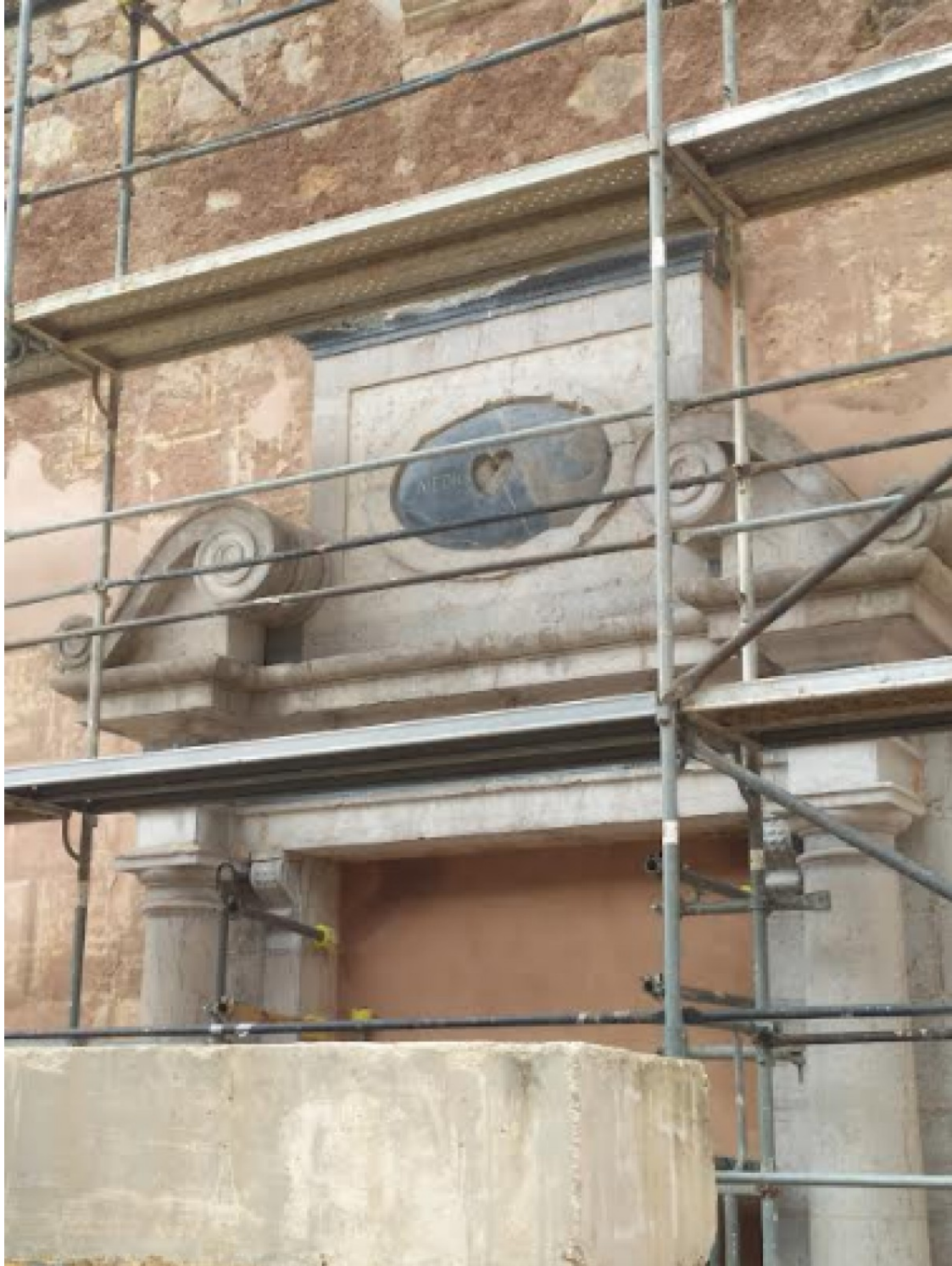
Imatge de les obres que es dues a terme a Escaladei Foto: Jordi Garcia
