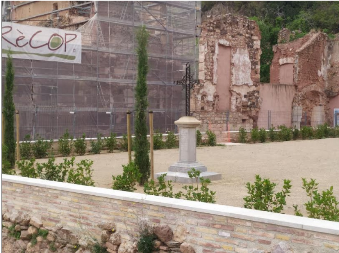
Imatge de les obres que es duen a terme a Escaladei | Jordi Garcia
