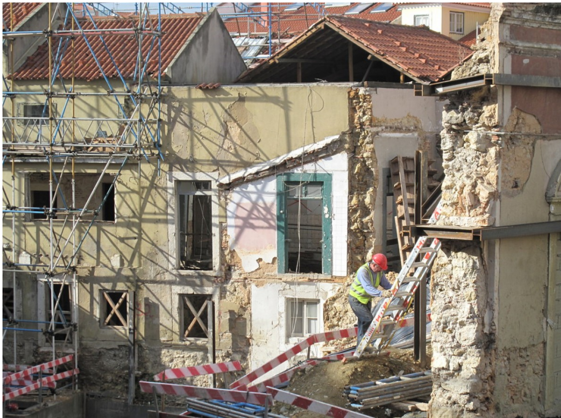
Imatge de recurs d'un edifici en obres | COAATT
