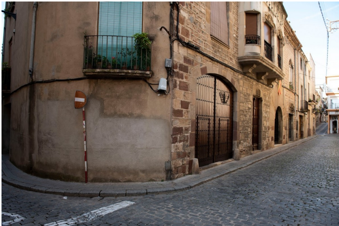
Exterior de la casa | Alex Plaza
